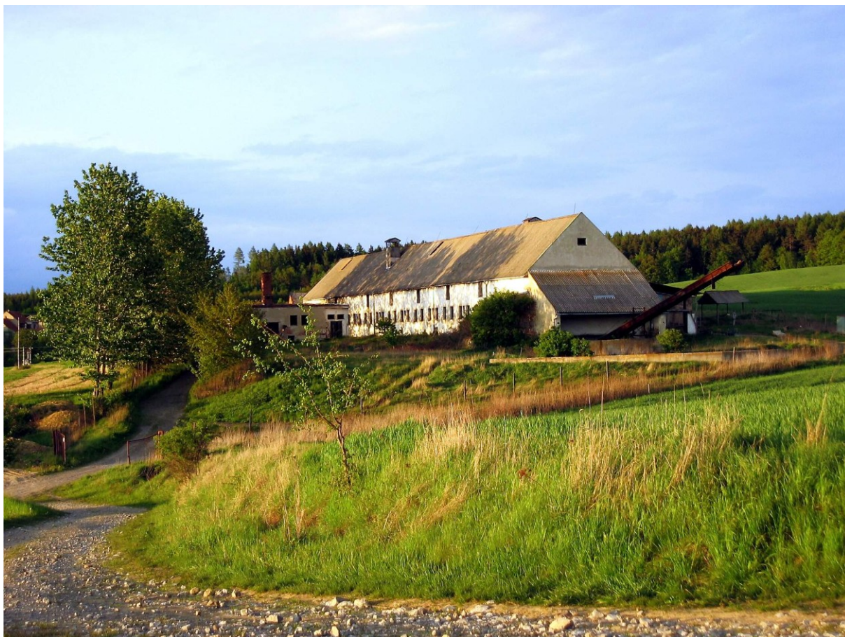
Obr. č. 8: Budova bývalého kravína před rekonstrukcí
