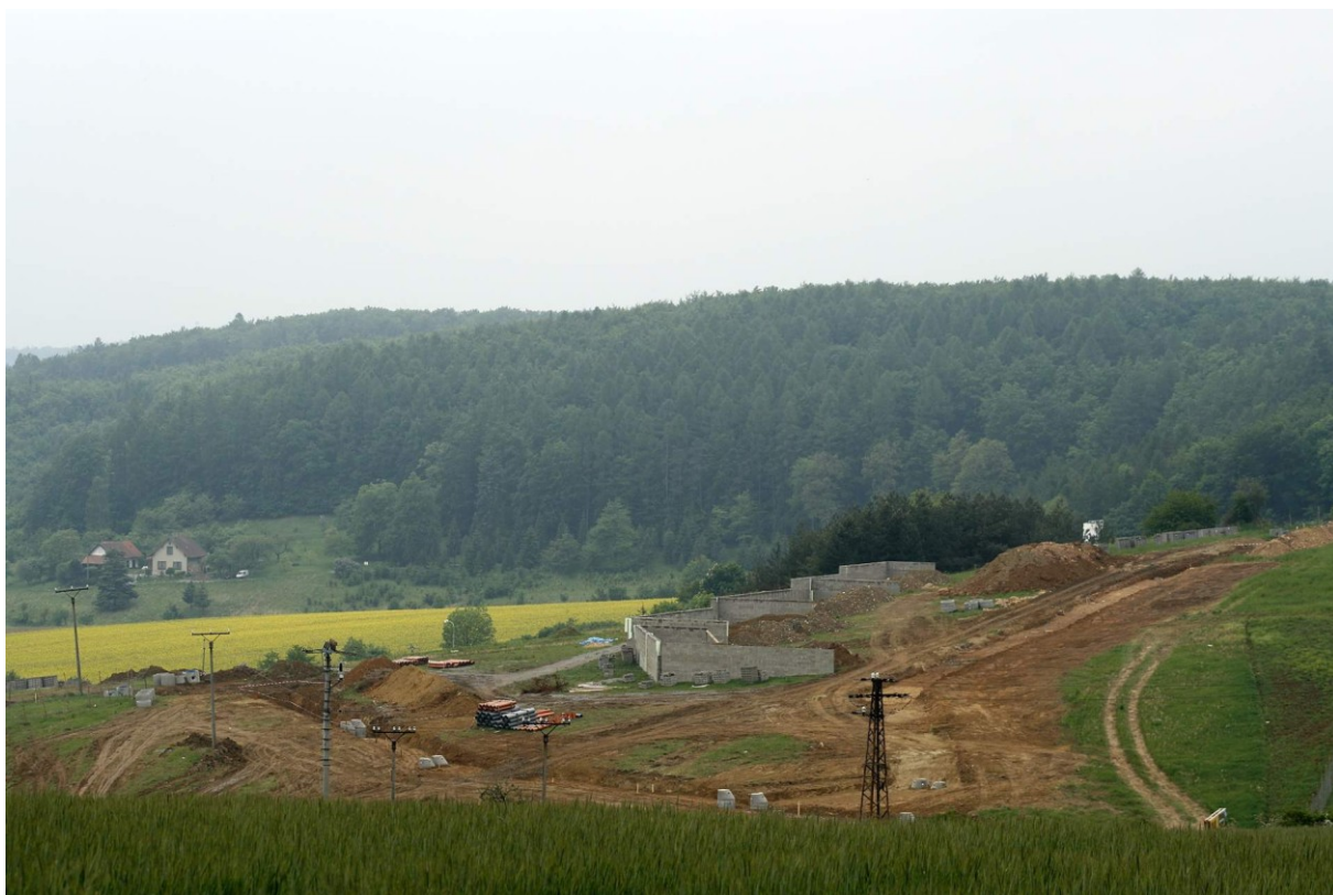
Obr. č. 4: Staveniště na Vysoké
